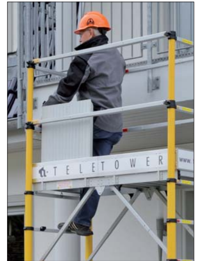
Aufstieg durch Klappe in der Plattform
